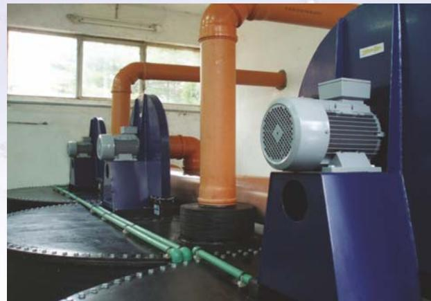
U slučaju akcidenta, vazduh sa netolerabilnom koncentracijom gasnog hlora, uvodi se u posudu sa distributerima, gde se disperzijom gasne mešavine u rastvoru za neutralizaciju vrši trenutna neutralizacija gasnog hlora iz gasne smeše.
