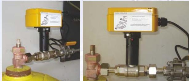
Napajanje detektora hlora i „SHUT OFF“ sistema je nezavisno, preko UPS uređaja. Ovakva izvedba omogućava nezavisan rad sistema i u slučaju nestanka električne energije što pruža dodatnu sigurnost u slučaju akcidenta.
