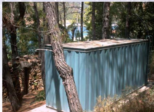
Po završetku procesa aeracije počinje faza taloženja unutar iste zapremine. Za vreme ovog procesa, otpadna voda tretirana biološki, separiše se od aktivnog mulja. Posle razdvajanja, prečišćena voda se evakuše dekanterom - pumpom. Prečišćena voda se konačno podvrgava dezinfekciji tečnim hlorom ili UV zracima. Tako tretirana voda se može dalje dodatno prečišćavati za irigacione ili neke druge svrhe.
